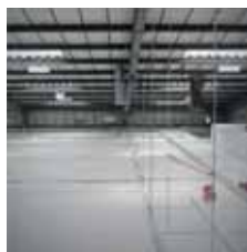
Armatures Unités clim Signalétique
